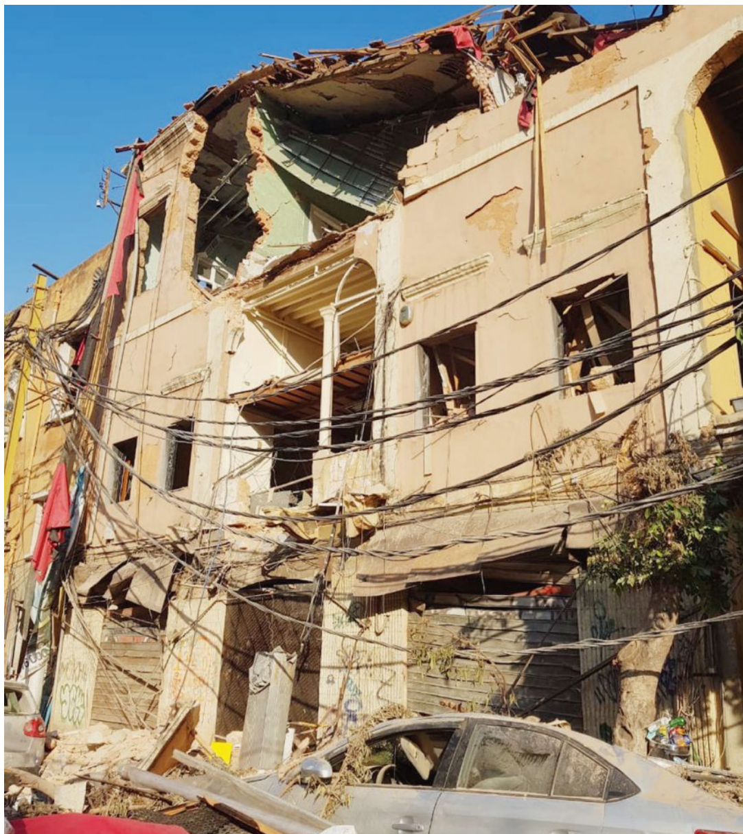
La plupart des portes et des fenêtres ont été emportées par le souffle de la déflagration. LDD
